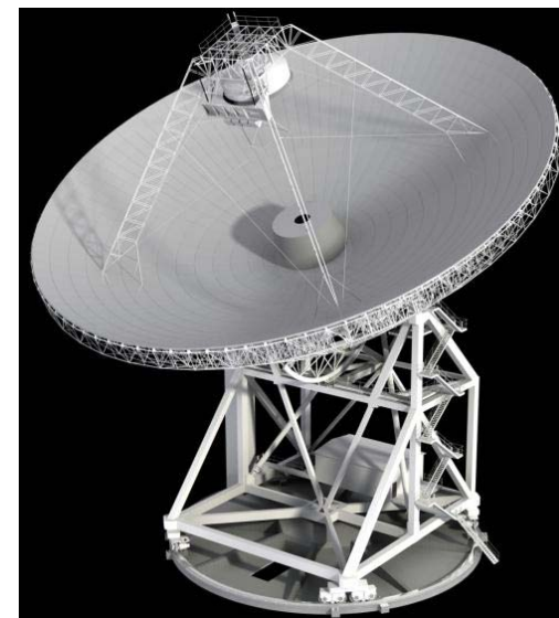
Il radiotelescopio SRT. L'antenna sarà alta circa 80 metri e peserà 3000 tonnellate.
